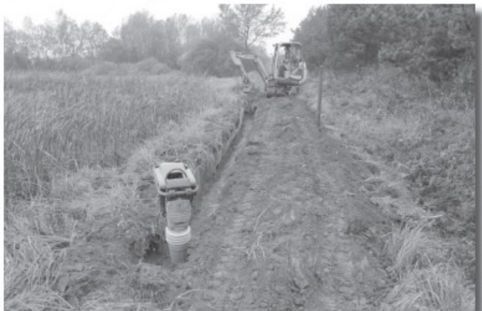
Oprava hráze tůně v PP Laguna u Bohdalova, 9. 10. 2014
