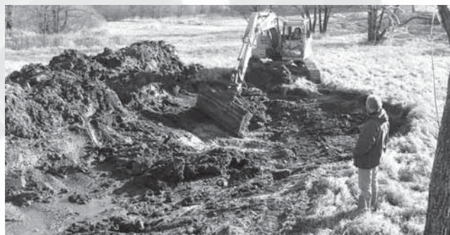
Nové tůně na Stavišti, 16. 11. 2015
